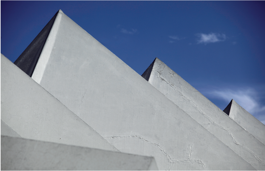
Detalle de cubierta de la capilla San Ignacio, Colegio Externado de San José, San Salvador (S. Choussy p., 1962) Fotografía de Óscar Leiva (2012), propiedad de Fundación AccesArte
